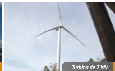
Turbina de 7 MV
