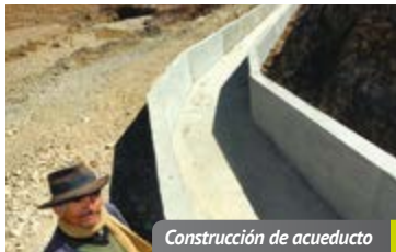
Construcción de acueducto
