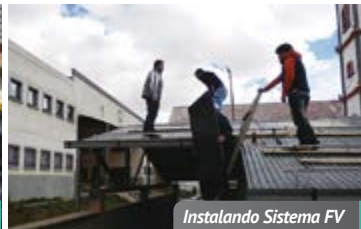
Instalando Sistema FV
