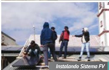
Instalando Sistema FV
