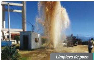
Limpieza de pozo
