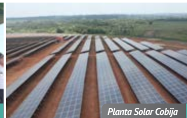
Planta Solar Cobija
