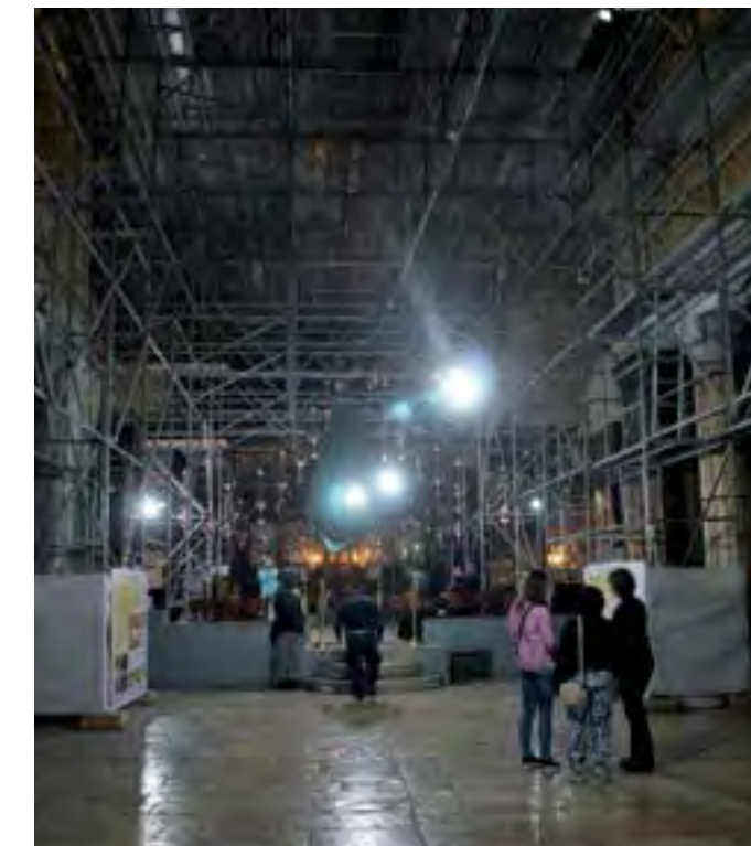
Eingerüstetes Kirchenschiff Scaffolding in the nave La nef sous les échafaudages
