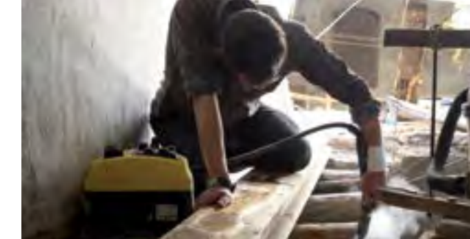
Konservierungs- und Restaurierungsarbeiten an der Galerie im Obergeschoss der östlichen Qaisariya, 2012 Conservation and restoration work on the gallery in the upper storey of the eastern Qaisariya, 2012 Travaux de conservation et de restauration sur la galerie au premier étage de la qaisariya est, 2012
