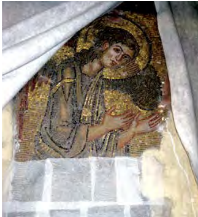
Jahrhundertlang unberührte Mosaiken unter dem sonst unzugänglichen Dach Mosaics untouched for centuries under the otherwise inaccessible roof Des mosaïques demeurées intactes pendant des siècles sous le toit inaccessible
