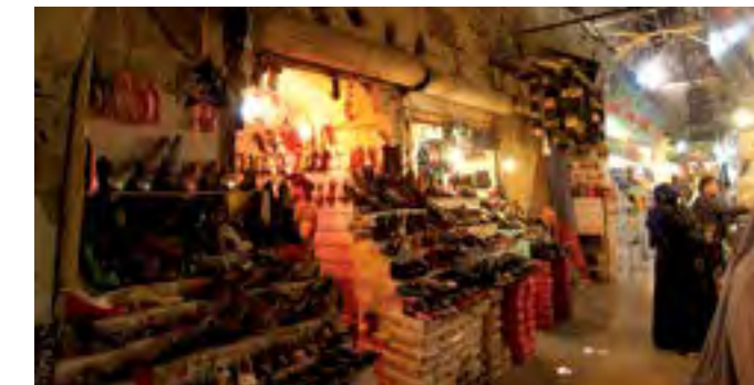
Schuhbasar in einem Gang der westlichen Qaisariya unter einem behelfsmäßigen Wellblechdach anstelle des eingestürzten Tonnengewölbes, 2013 Shoe bazaar in a walkway in the western Qaisariya under a temporary corrugated iron roof in place of the collapsed barrel vault, 2013 Échoppe de chaussures dans une galerie de la qaisariya ouest sous un toit provisoire en tôle remplaçant la voûte en berceau effondrée, 2013
