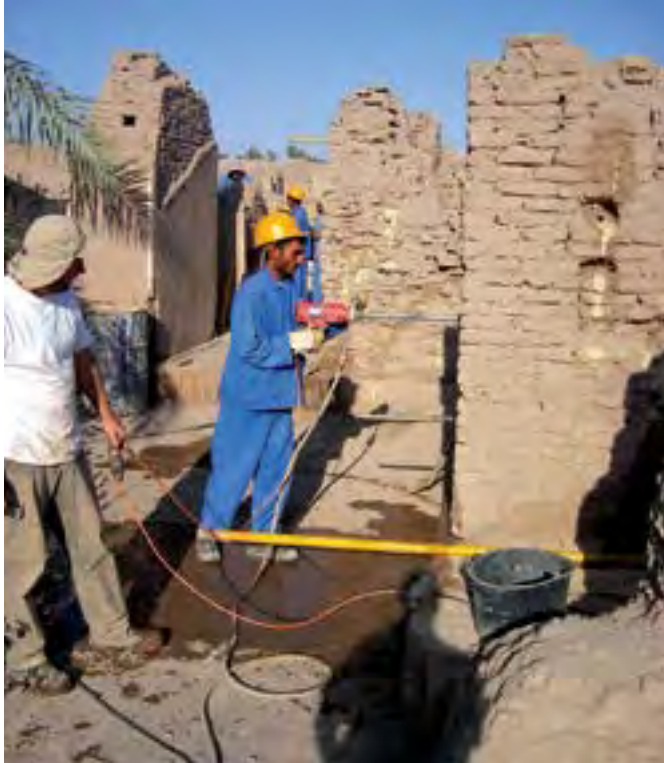
Bohren der Nadellöcher Drilling the holes Forage des points d'injection
