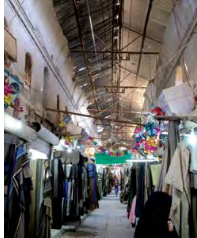
Ladenzeile mit Schneiderwerkstätten in der östlichen Qaisariya, darüber die Reste des eingestürzten Gewölbes und ein behelfsmäßiges Wellblechdach, 2011 Row of shops with tailors' workshops in the eastern Qaisariya below the ruins of the collapsed vault and a temporary corrugated iron roof, 2011 Galerie des tailleurs dans la qaisariya est, au-dessus, restes de la voûte effondrée et toit provisoire en tôle, 2011
