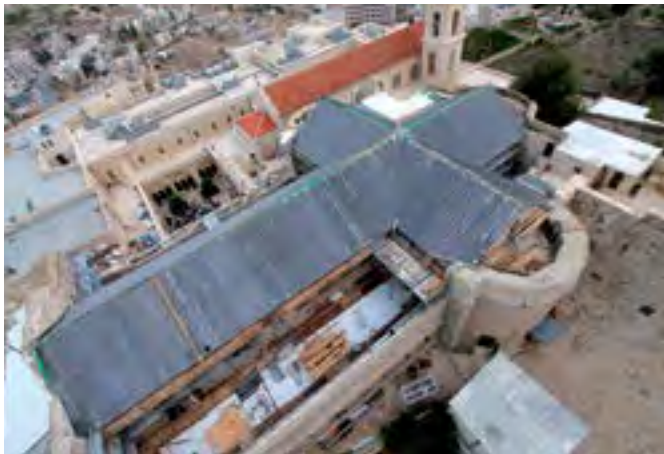
Restaurierung des zuvor stark beschädigten Daches der Geburtskirche Restoration of the badly damaged roof of the Church of the Nativity Restauration de la toiture très endommagée
