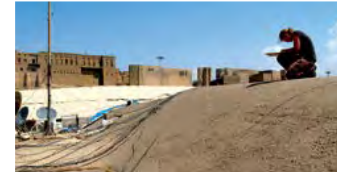
Baufahrnarbeiten auf den Gewölbetonnen über den Gängen der westlichen Qaisariya, im Hintergrund die Zitadelle von Erbil, 2013 Architectural documentation work on the barrel vaults over the walkways of the western Qaisariya, with the Erbil citadel in the background, 2013 Début des travaux sur les voûtes en berceau au-dessus des galeries de la qaisariya ouest, en arrière plan la citadelle d'Erbil, 2013
