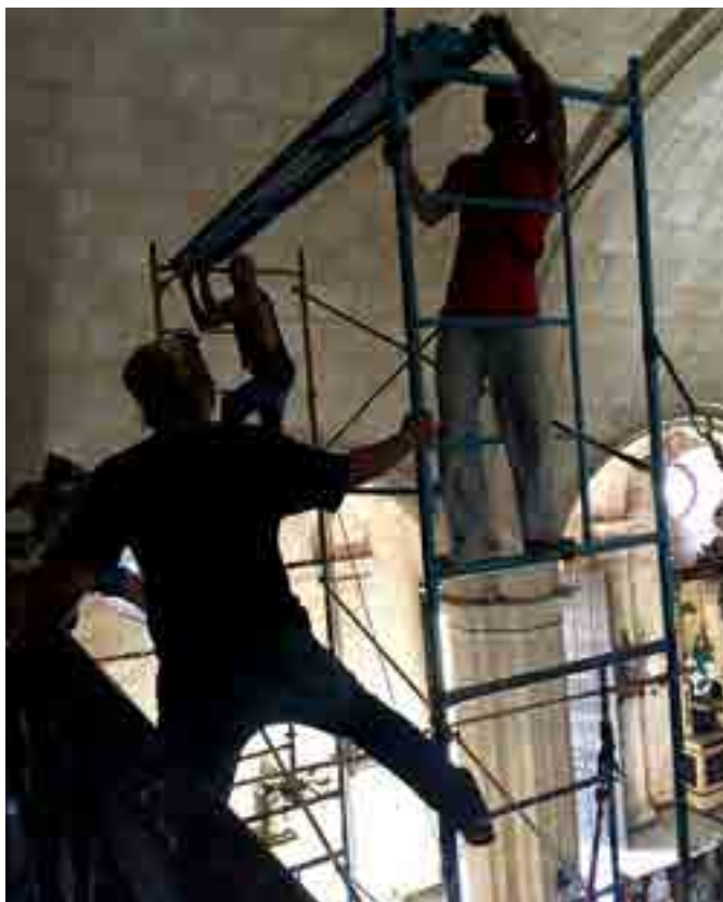
↑ Kubanische Improvisation und Einfallsreichtum waren gefragt, um die 200 Kilogramm schwere Kegelwindlade abzuseilen Para poder bajar el secreto de más de 200 kilos hubo que recurrir a la improvisación y la creatividad propia de los cubanos
