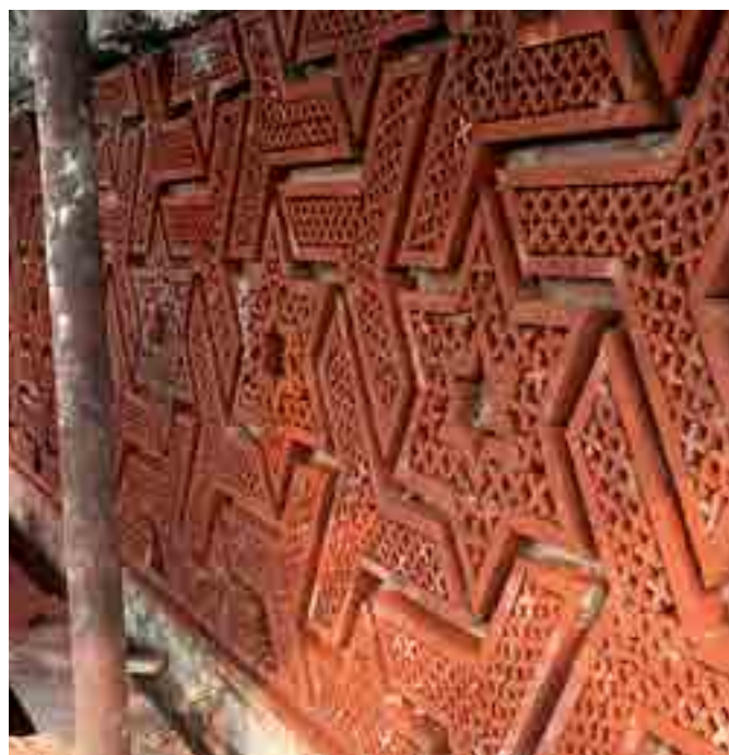
↓ Wiederherstellung der Filigranarbeiten im Prototypbereich der Schmuckmauer Reconstrucción de un trabajo de filigrana en el segmento prototipo de la muralla decorada
