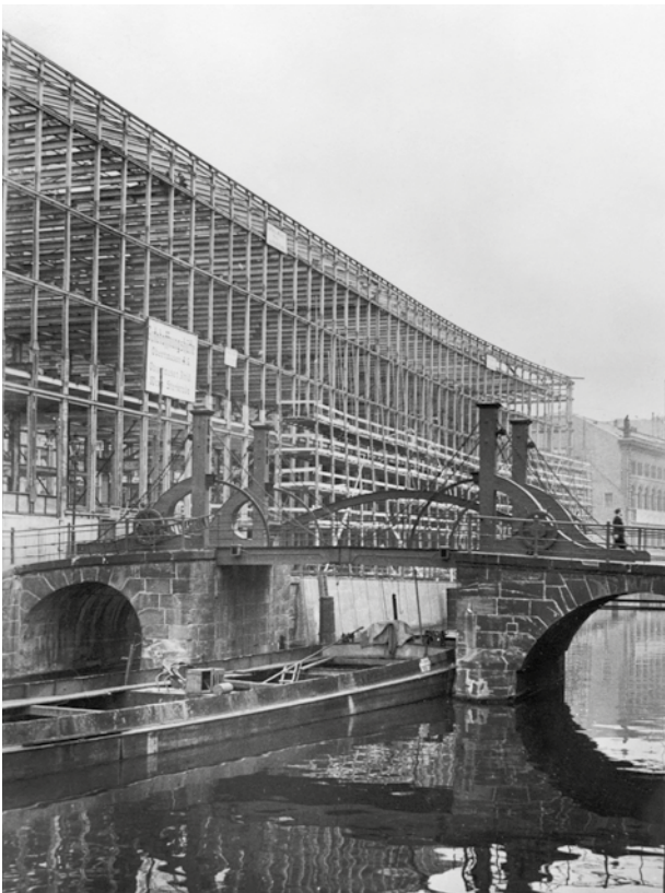
1936, Blick auf die Stahlgerüstkonstruktion des Reichsbankneubaus in Berlin The steel framework of the new Reichsbank building, Berlin, 1936
