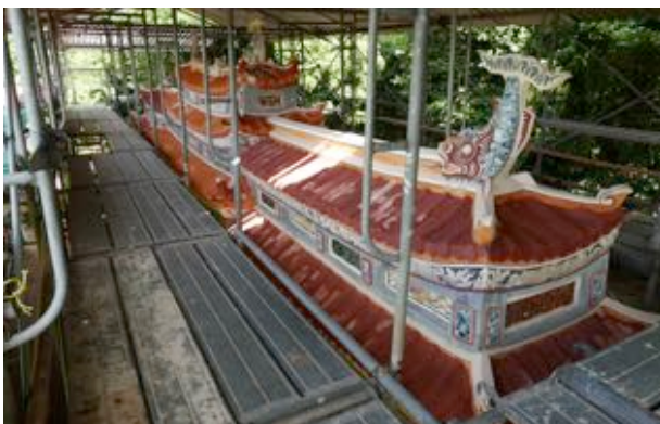
Phần đỉnh mái của cổng sau khi được bảo tồn và phục hồi
