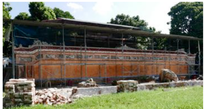
Bình phong sau khi được bảo tồn và phục hồi (phần Non bộ vẫn đang được thi công)
