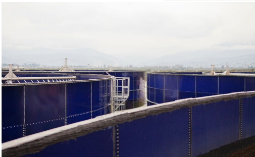
Kläranlage in Batumi, © KfW-Bildarchiv/Rendel Freude
